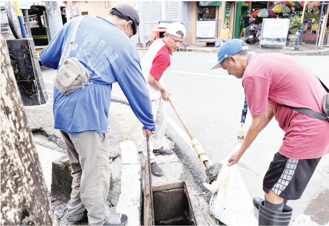
馬尼拉工程與公共工程部的工作人員8月18日上午在馬尼拉伊班迎大道沿線的排水溝進行清淤。
