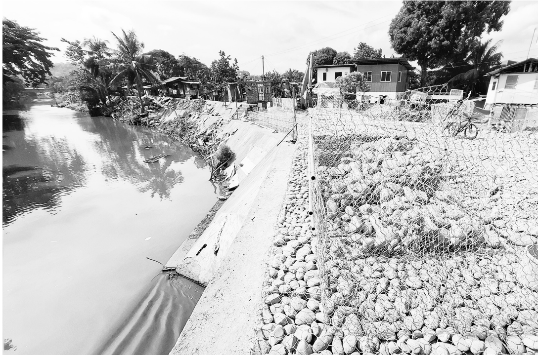
8月17日在納印市邦卡爾的塔阿爾2可見到正在進行的防洪工程，包括在塔羅莫河沿線安裝蛇籠結構。在7月24日發生嚴重洪水後，公造部已下令立即修復堤防並疏浚河流。
