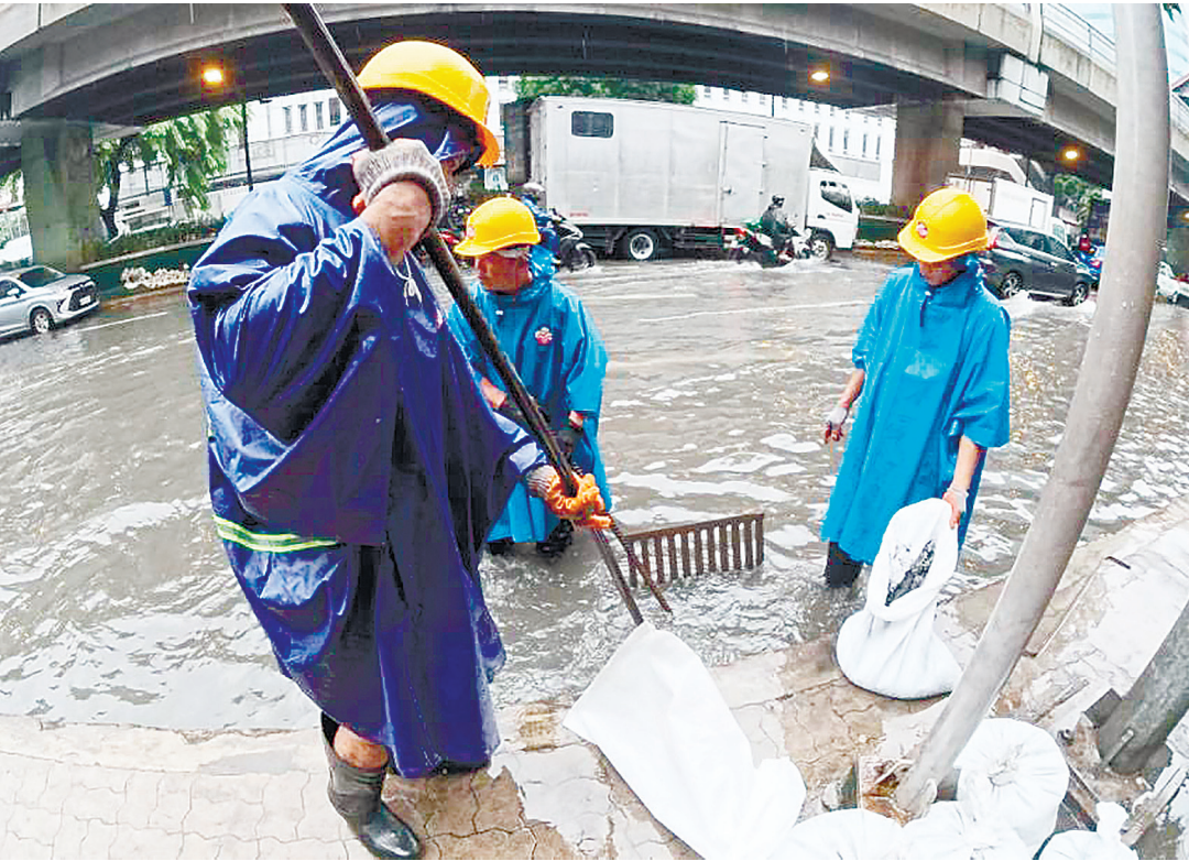
大岷區發展署於8月14日在馬尼拉薩美省區塔夫脫大道沿線清除被困在孔中的垃圾，當時西南季風帶來的強降雨導致洪水達到水溝深度。
