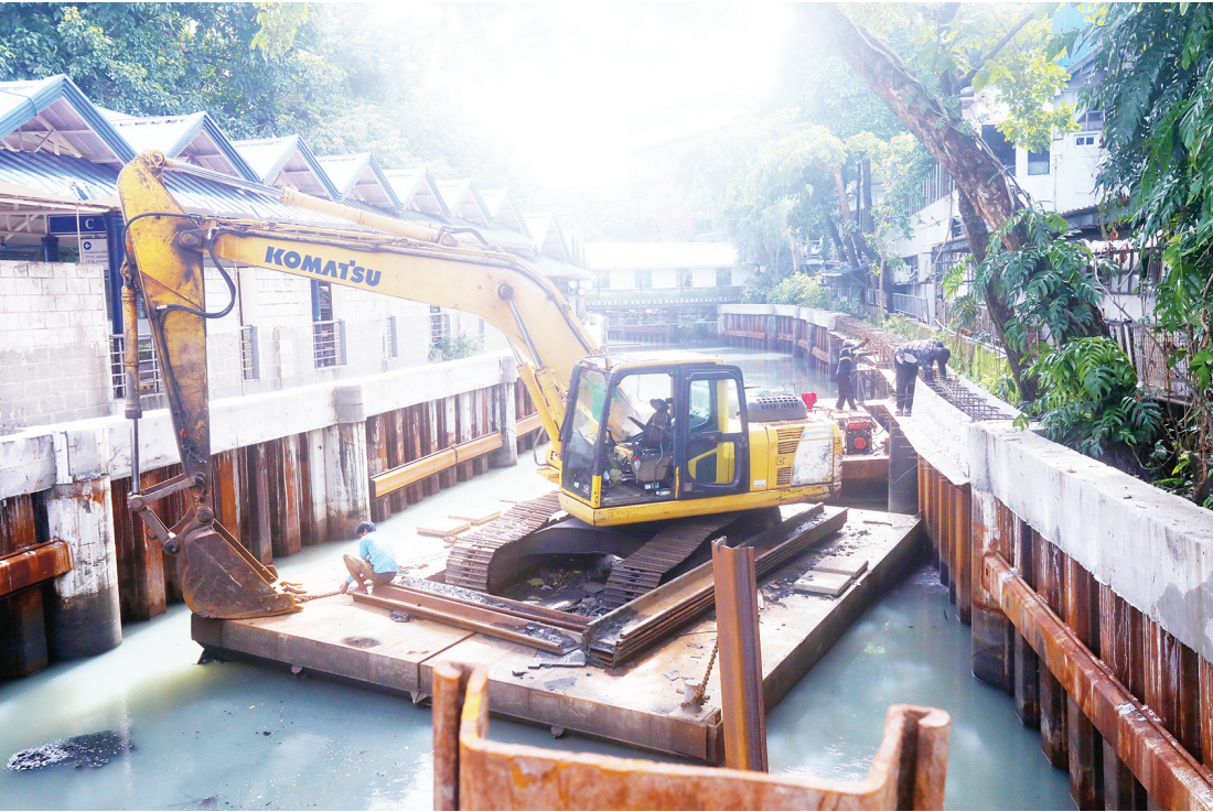
工人於週一在馬尼拉仙馬西仁諾街沿線的一條溪流中，在鋼板樁牆上組裝結構橫樑。鋼板樁可防止土壤侵蝕，並作為施工的安全屏障。
