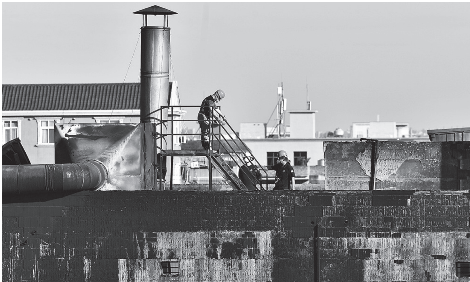
▲7月9日12時4分，晉江市陳埭鎮江頭村輝騰鞋業有限公司廠房發生火災。圖為7月10日，工作人員在火災廠房的樓頂開展事故勘驗工作。 中新社
