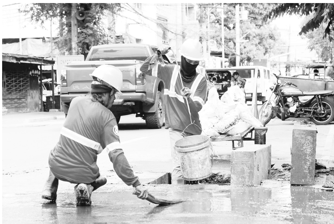
大岷區發展署於週五在馬尼拉市三巴洛區易淹水的未申智·G·古律斯街進行疏通和清理作業。大岷區發展署的目標是透過現代化改造36座現有抽水站、建造20座新抽水站、管理水道沿線的固體廢棄物以及遷移非正式居民，來降低大岷區的淹水風險。
