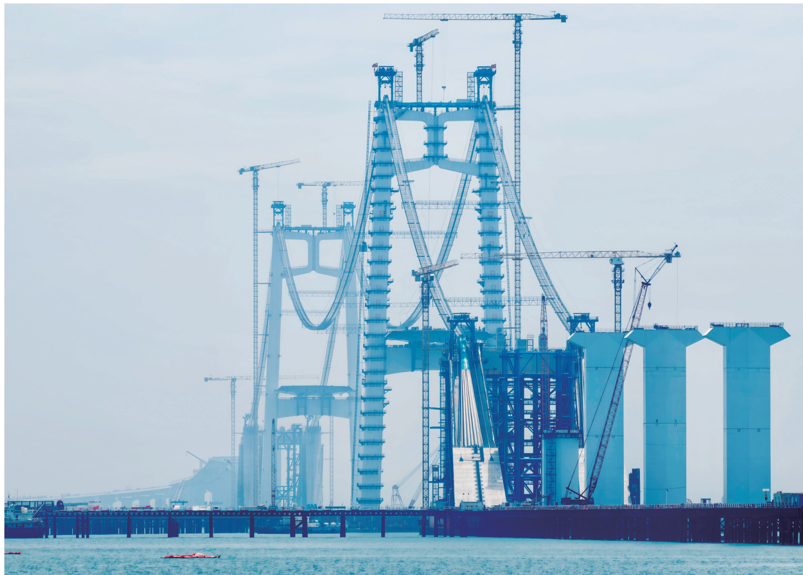
福建廈門：建設中的廈門大橋(廈門段) 5月24日，福建廈門，正在建設中的廈門大橋(廈門段)。廈門大橋(廈門段)起於福建廈門環島東路與會展北路交叉口，終點設互通接入廈門翔安國際機場，並預留至金門段接口，路線全長約19.6公里。 〈中新社〉
