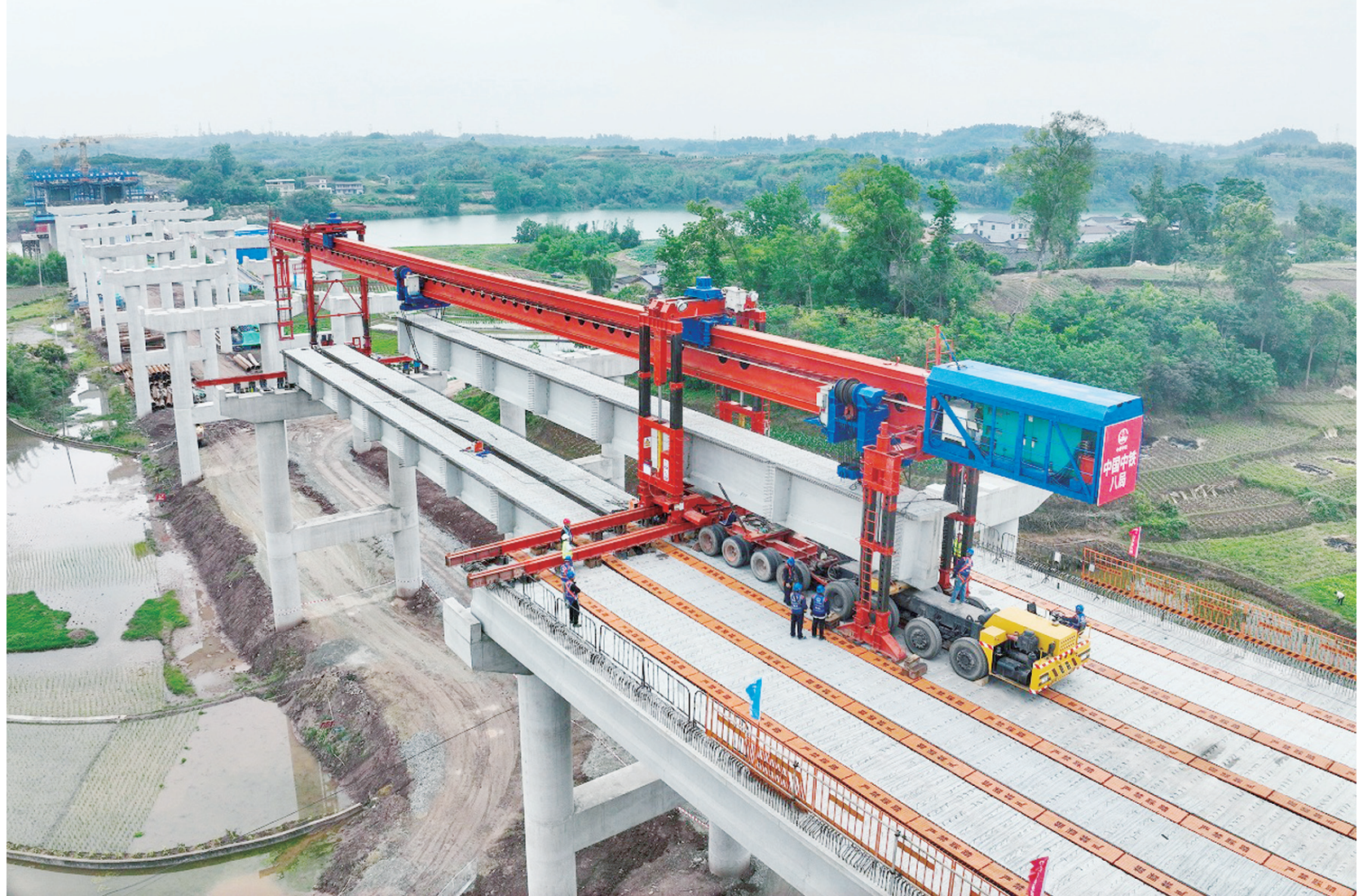
四川自貢至重慶永川高速公路沱江特大橋建設穩步推進
