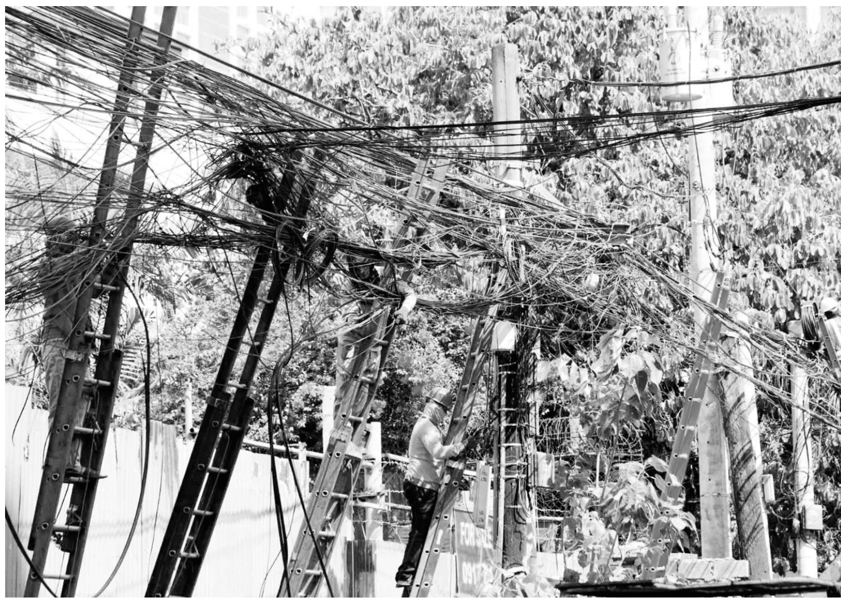
4月22日，電纜公司工人在馬尼拉薩美峇區雷梅迪奧斯街拆除懸掛的電線，這是全市範圍內確保安全和改善美觀舉措的一部份。
