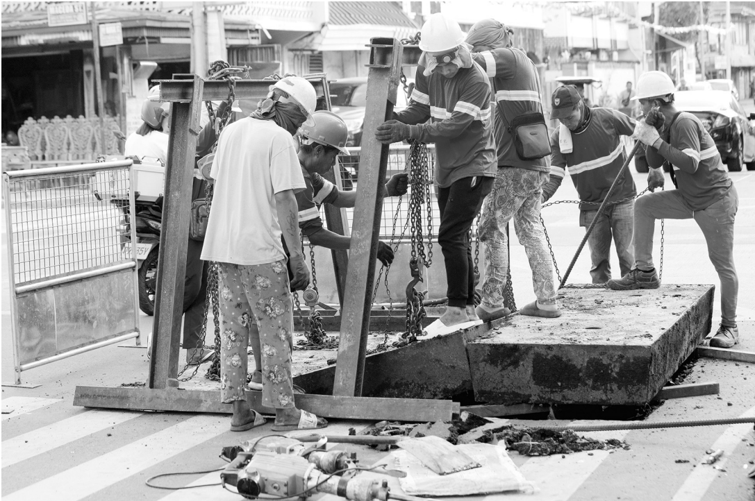
公造部工人2月5日在馬尼拉市更換一個檢修孔蓋。此項維護工作是持續進行的雨季防澇工程之一，旨在確保行人與駕駛者的安全。
