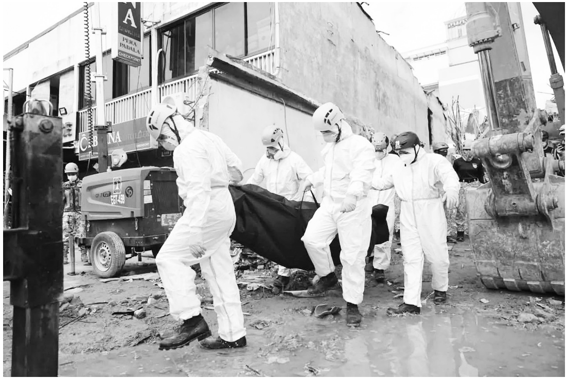
據消防局中呂宋分局週三稱，邦邦省紅叉禮斯市一棟九層在建建築倒塌事件的死亡人數已升至27人。
