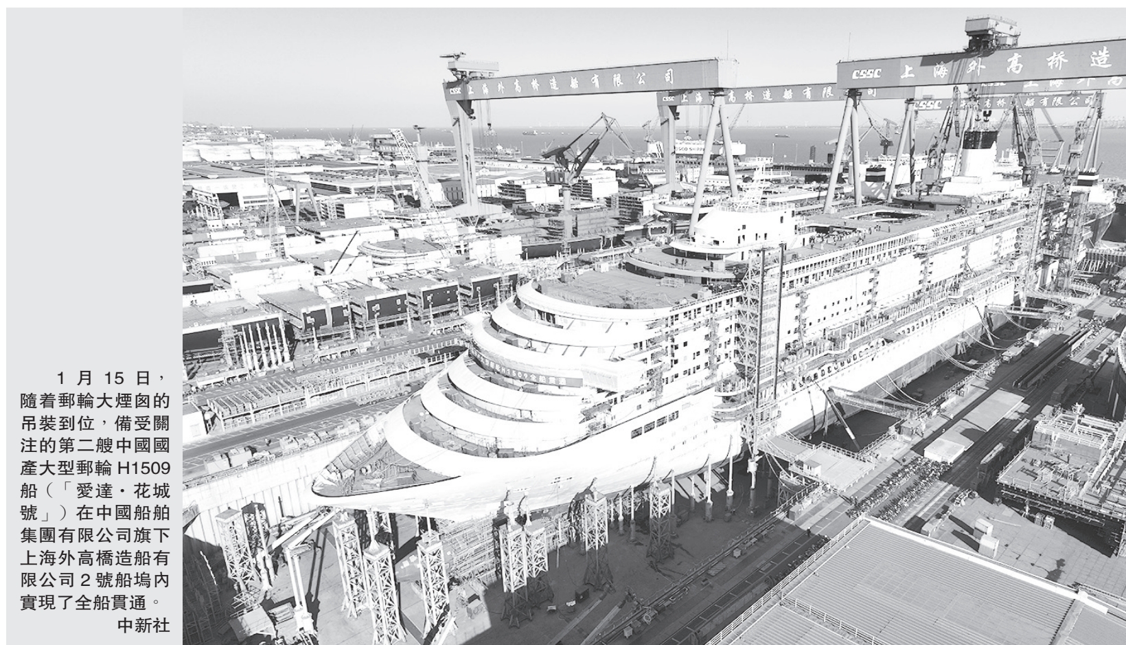
1月15日，隨着郵輪大煙囪的吊裝到位，備受關注的第二艘中國國產大型郵輪 H1509 船（「愛達·花城號」）在中國船舶集團有限公司旗下上海外高橋造船有限公司 2 號船塢內實現了全船貫通。
