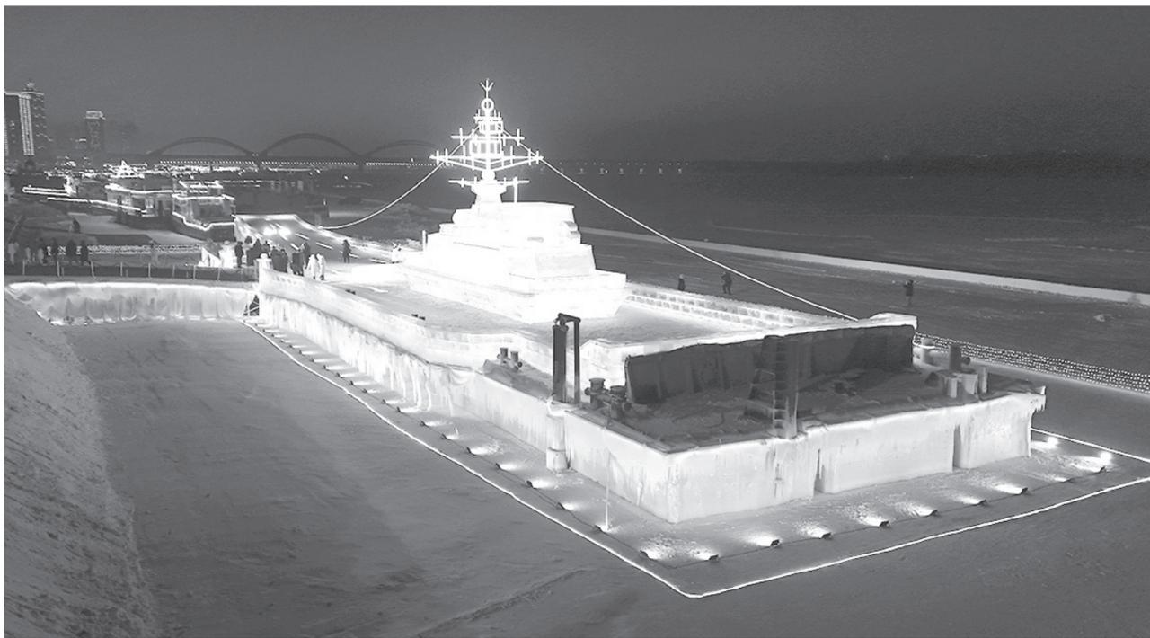
**冰雪遼寧艦** 1月6日，黑龍江哈爾濱，「冰雪遼寧艦」建造完成正式亮相。據瞭解，「冰雪遼寧艦」以一艘駁船為基底，以鋼結構為骨架，用冰塊搭建出外部造型，按照1比6的比例還原遼寧艦。
