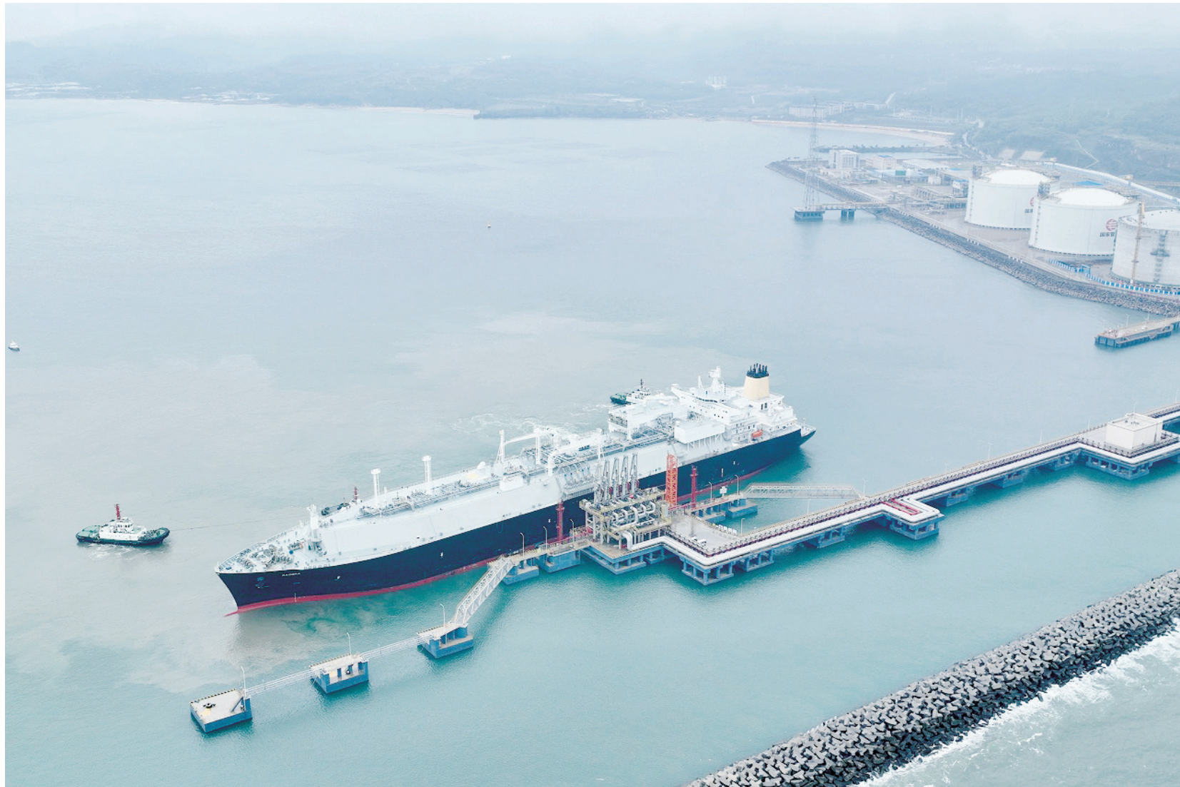
福建漳州15萬噸級LNG接收站碼頭首船靠泊 5月21日，載運6.6萬噸液化天然氣（折合天然氣15.7萬立方米）的巴哈馬籍LNG（液化天然氣）運輸船「瑪可瑪」輪順利靠泊福建漳州LNG接收站碼頭，這是該碼頭開港後迎來的首艘LNG船。漳州LNG項目作為福建省重點項目，是國家管網集團成立後第一個建成投產的LNG接收站，為15萬噸級。 <中新社>
