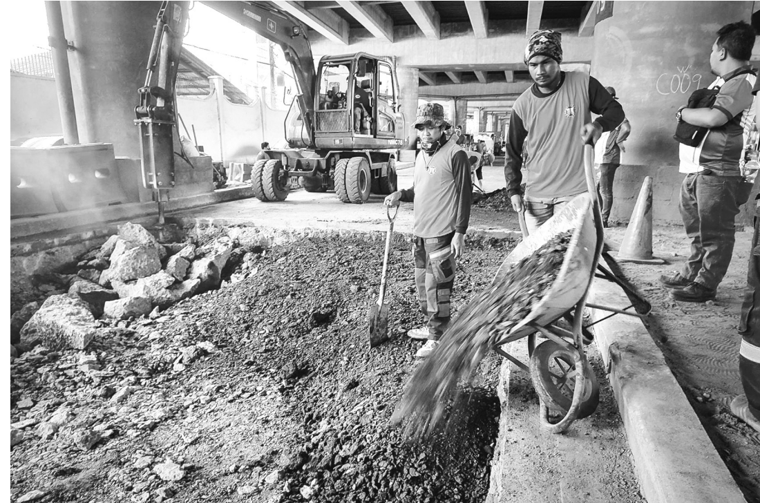
公造部工作人員昨日掩蓋巴西西尼蕊亞謹諾國際機場附近出現的大坑。
