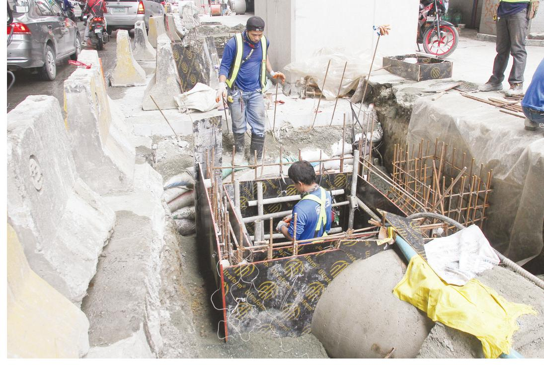
週四，EEI公司的工人在計順市的亞蘭尼沓大街上為防洪結構安裝一個箱形涵洞的鋼框架。箱涵是河道施工的主要材料之一，用於將道路一側的積水排到另一側。
