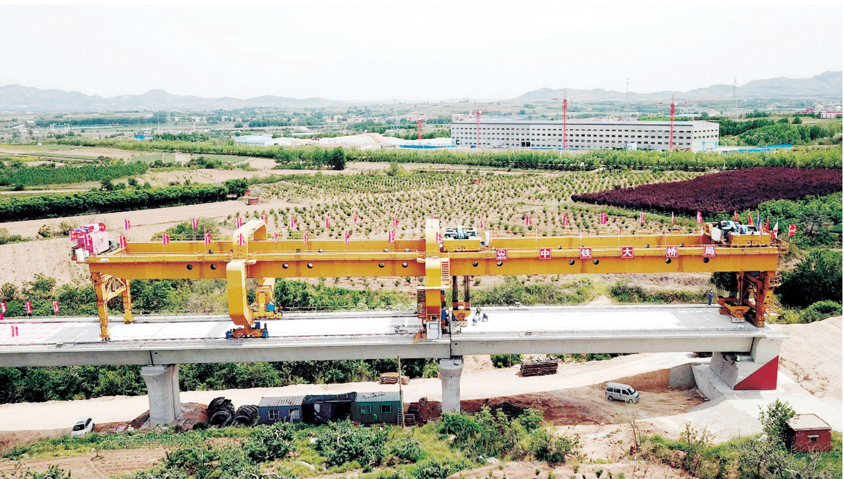
濰煙高鐵招遠段實現貫通 5月14日，中鐵大橋局工人在濰煙高鐵招遠段進行架樑作業。山東省重點基建項目——濰（坊）煙（台）高鐵施工方在嚴格防控疫情基礎上，積極復工復產。由中鐵大橋局承建的濰煙高鐵招遠段5月14日實現貫通，為後續鋪軌施工奠定了基礎。 <新華社>
